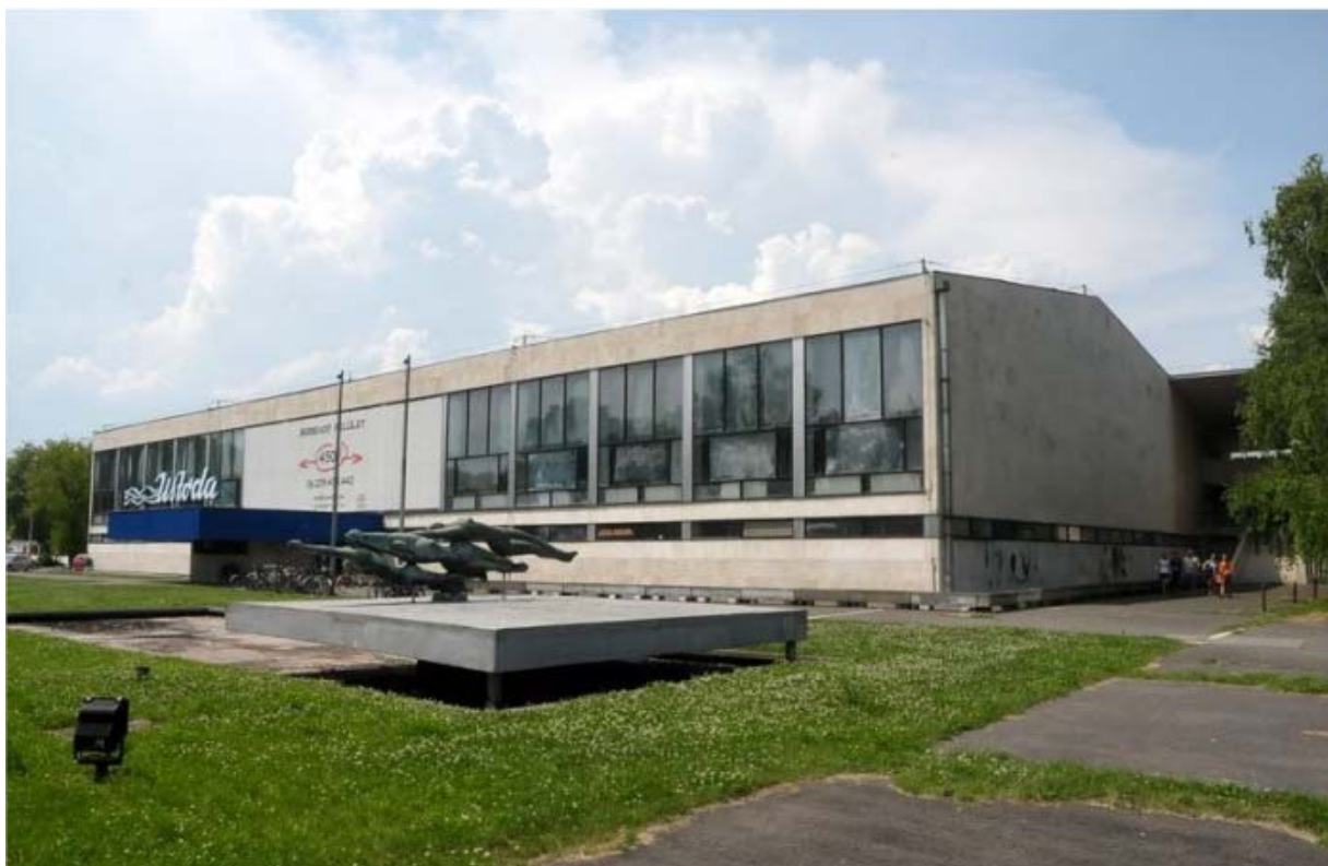
A hasznosításra váró volt fedett uszoda épülete
